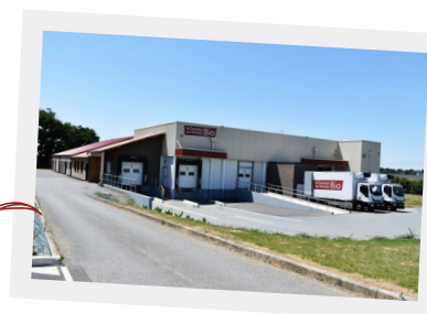
Extérieur du bâtiment
